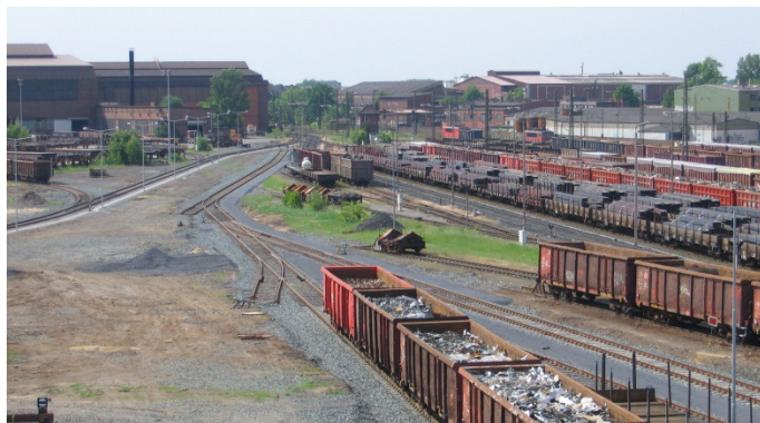
Werk Peine, Bauzustände
